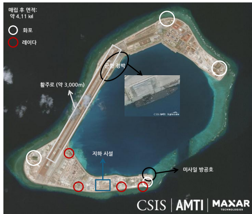
그림2 중국의 스프래틀리 군도 내 '수비 암호' 확장 현황
