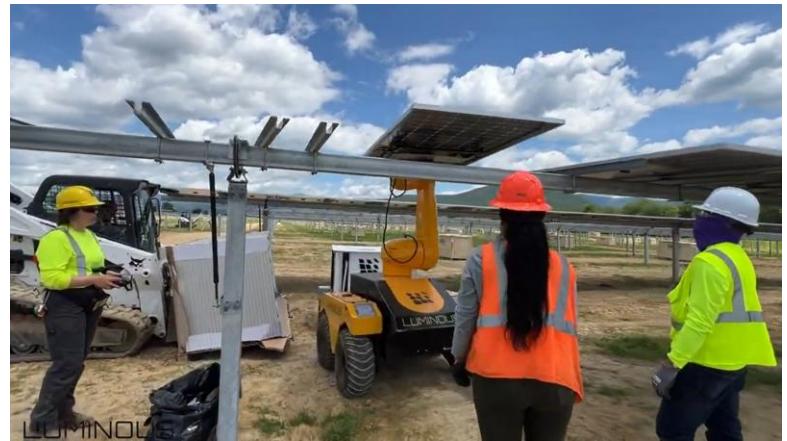
태양광 패널 설치 로봇
