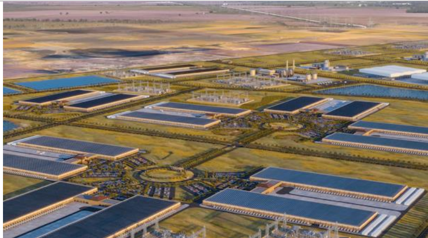
도표 4. 페르미 아메리카의 발전소 조감도
