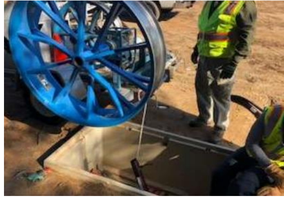
도표 67. 광케이블 매설 작업
