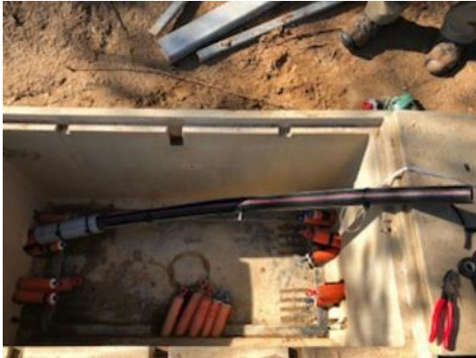
도표 66. 광케이블 매설 작업
