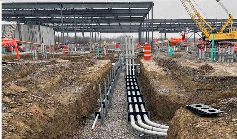
도표 64. 데이터센터 지중 케이블 관로 매설 작업
