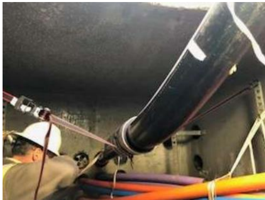
도표 68. 광케이블 매설 작업
