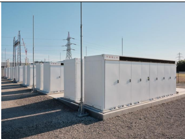
그림135. Tesla 메가팩 ESS
