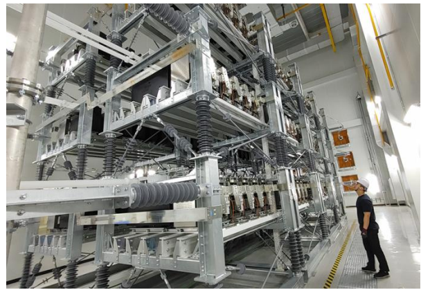
그림145. LS일렉트릭의 STATCOM
