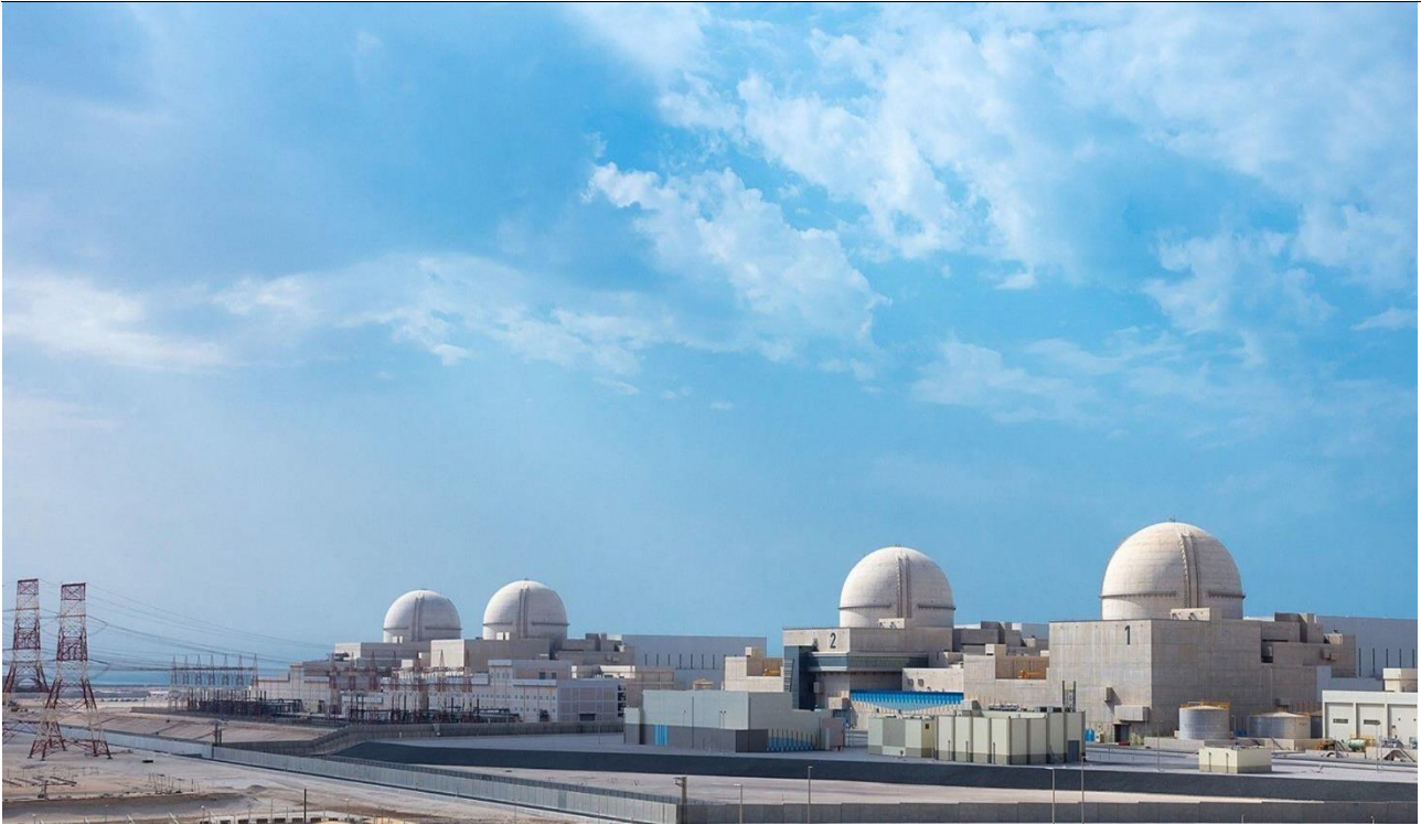
그림1.UAE 바라카 원전 1~4호기 전경
