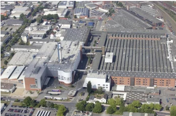
그림35. 라인메탈이 인수검토중인 폭스바겐 자동차 공장
