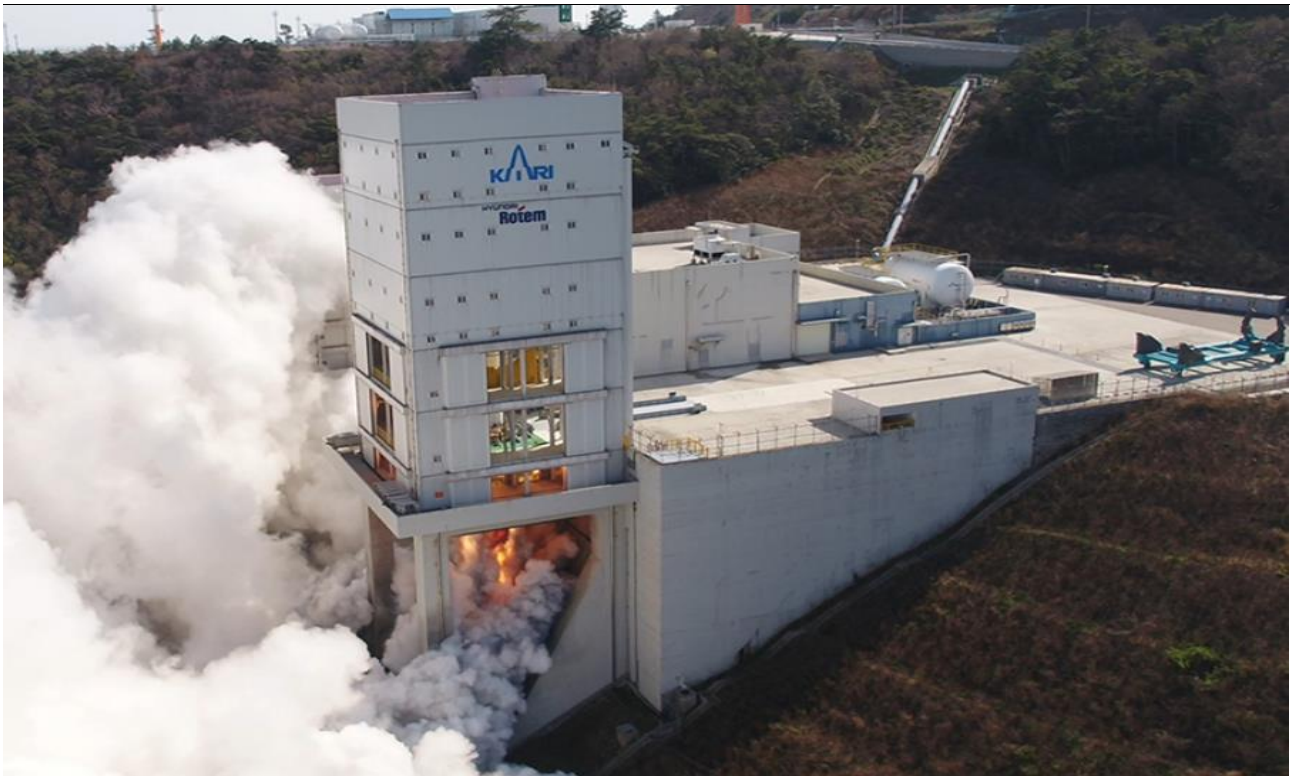
그림11.현대로템이 구축한 한국형발사체 추진기관시스템 시험설비
