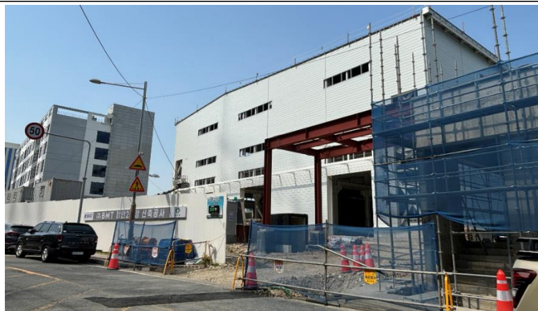
그림 302. 건설 중인 기장 신공장 전경
