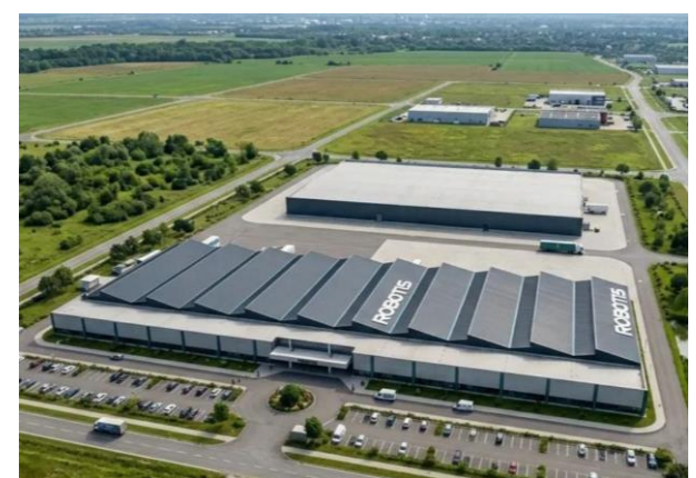
그림 271. 로보티즈 우즈베키스탄 생산공장
