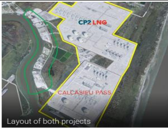
그림 176. Calcasieu Pass 플랜트 전경
