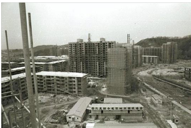
그림 25. 목동신시가지 공사현장 모습
