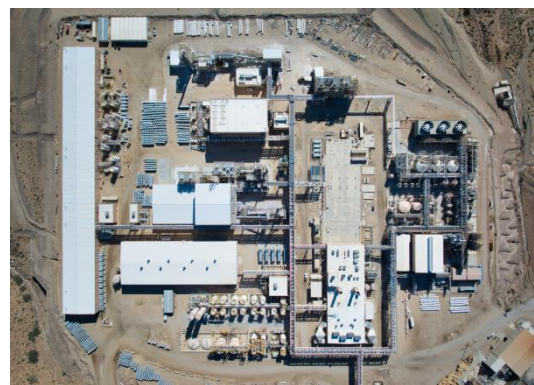
MP materials 희토류 플랜트
