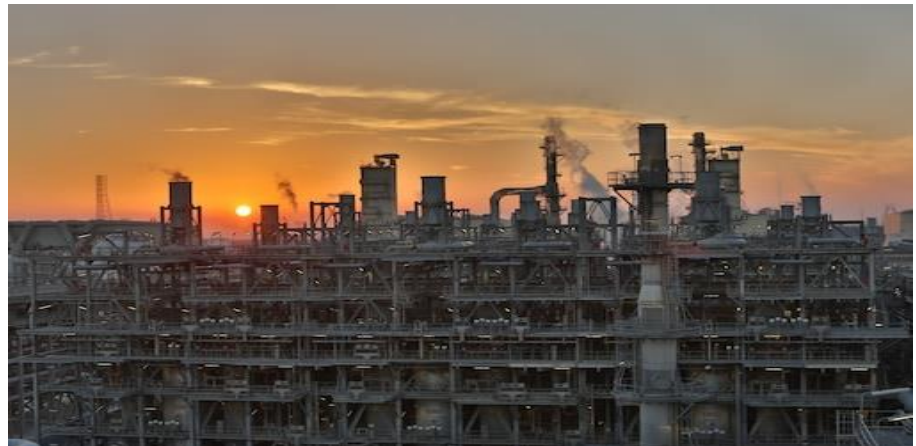
그림 11. Pearl GTL 전경
