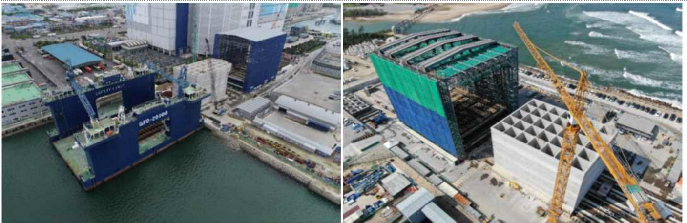
그림 4. 인천신항 1-2단계 컨테이너 부두 공사(좌), 강릉 안인화력발전소 케이슨 설치공사(우)
