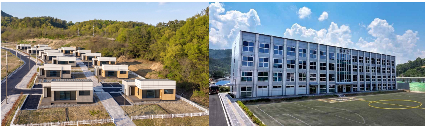
그림 6. 모듈러 건축 시공 예시
