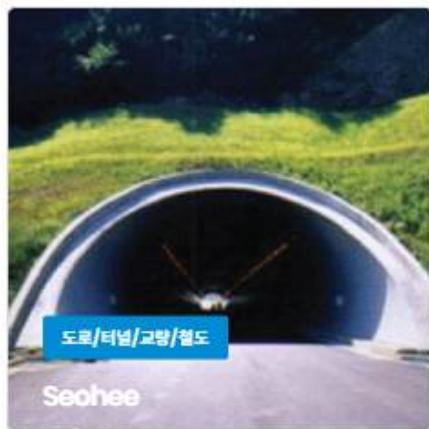
단월-도계간 도로확장 포장공사
