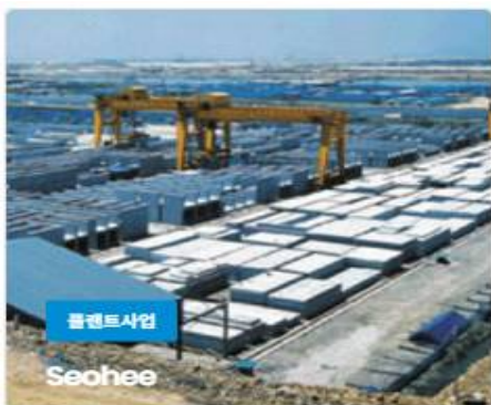
인천 국제공항 PC 배수구조물 공사
