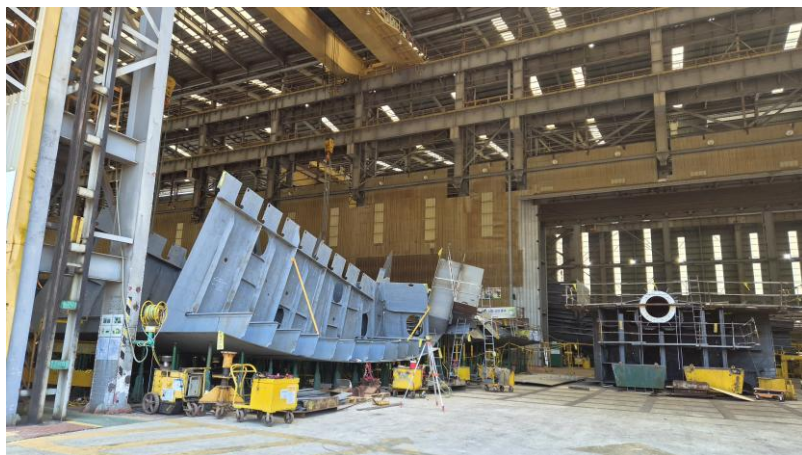
그림9 대한조선 내업 1공장 곡블록 조립공장 전경
