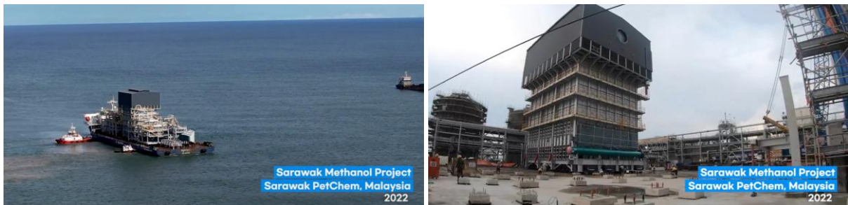
도표 12. 삼성 E&A 모듈화(Modularization) 사례
