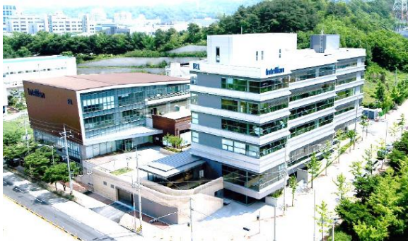
도표 6. 인텔리안테크 평택 R&D 센터 및 제 1 공장
