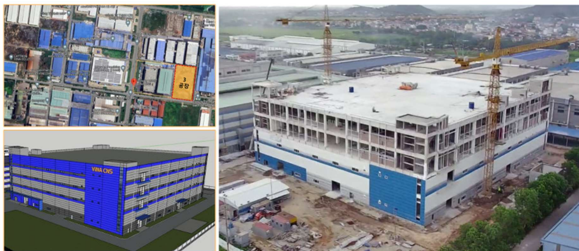
도표 19. 3 공장 건축현장 (공정률 87% 진행 중)
