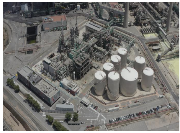
그림15. ILBOC 윤활기유 생산공장(3)
