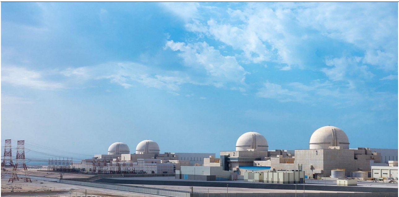
그림17. UAE 바라카 원전 1~4호기 전경
