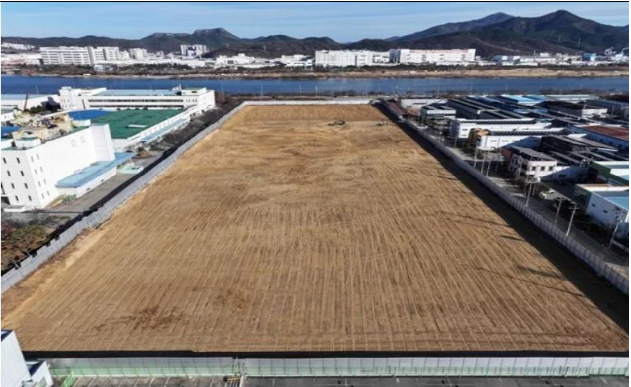
그림9. 구미 AI 데이터센터를 구축할 예정인 옛 삼성전자 구미1사업장 부지 전경
