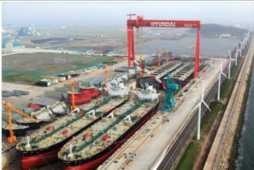
그림 3. 군산조선소 전경: 세계 최대 규모의 도크 보유, 대형 컨테이너선 및 원유운반선 4척 동시 건조 가능
