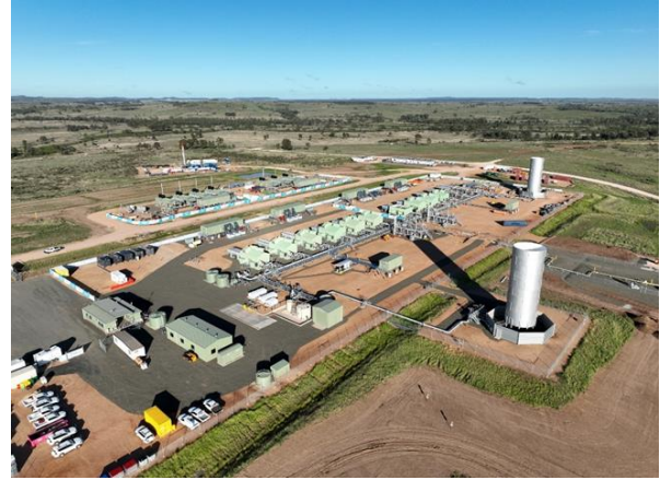
그림 2. SENEX 아틀라스 가스전 가스처리시설 전경
