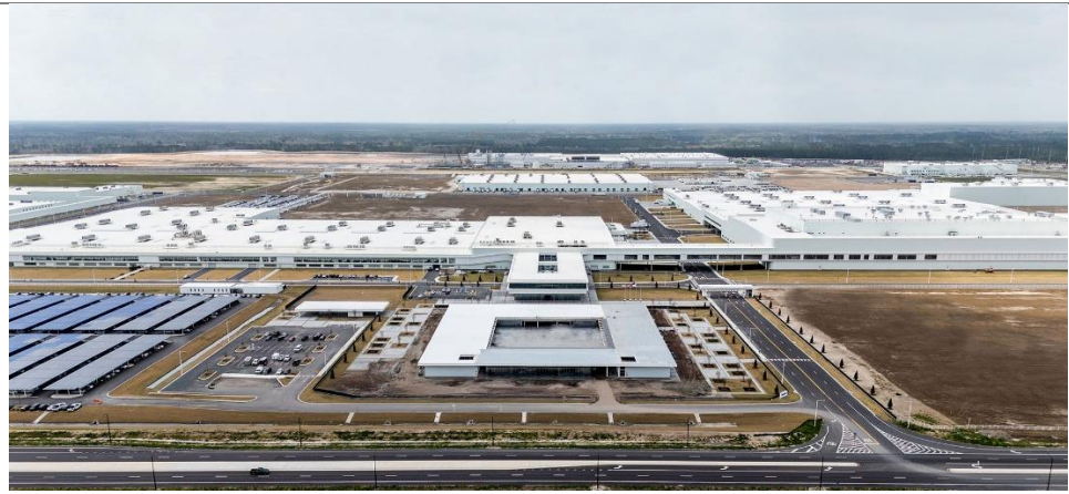
[도표 2] 현대차 HMGMA 공장 부지
