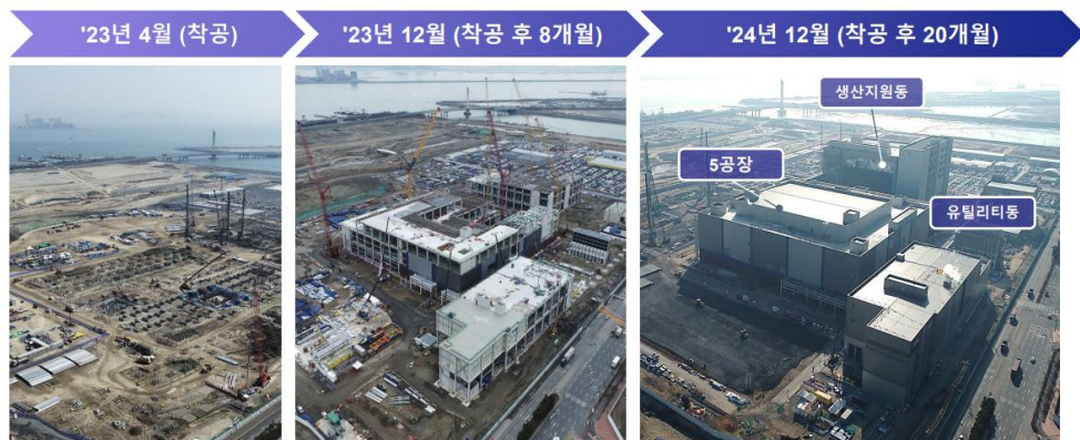
그림 4. 5공장 건설 경과
