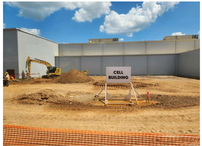
그림 11. 착공 중인 카터스빌 셀 공장
